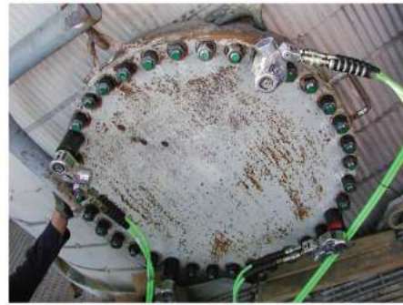
炼油厂人孔法兰，4部AVANTI-3同步紧固、快速、安全、可靠
