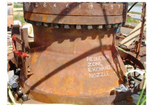
石化厂还原交换器喷嘴法兰螺栓尺寸1-1/2"，使用AVANTI-3四同步紧固
