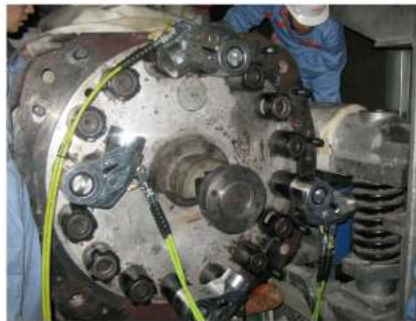
配合HYTORC螺母无偏载轴向拉伸紧固
