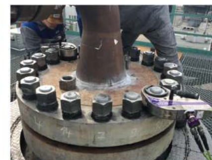
配合HYTORC垫圈无偏载轴向拉伸紧固
