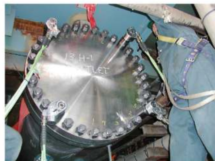
石化厂热交换器出口法兰螺栓紧固，螺栓直径1-5/8"，4部AVANTI-3同步紧固，快速、安全、可靠。
