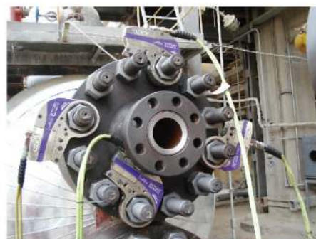
化肥厂中置锅炉法兰螺栓紧固，螺栓直径：M80，4部STEALTH-14同步紧固，快速、安全、可靠。
