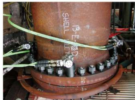
石化厂热交换器入口法兰螺栓紧固，螺栓直径1-5/8"，4部AVANTI-3同步紧固，快速、安全、可靠。
