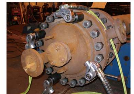
石化厂反应器入口法兰螺栓尺寸1-3/4"，使用AVANTI-5四同步紧固
